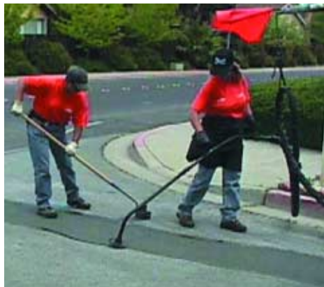
Equipos de obreros reparan las calles por parte del Programa de Mantenimiento del Pavimento. La ciudad invierte cientos de miles de dólares cada año en programas para mantener las calles de los vecindarios en buenas condiciones.
